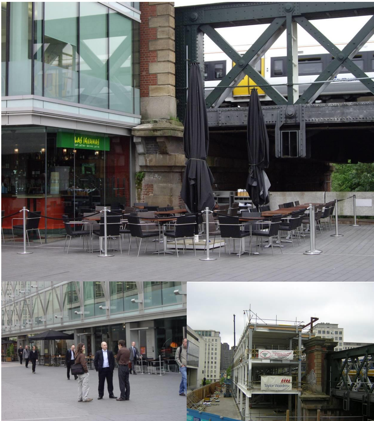
Figur 2.15. En ny byggnad avskärmar konserthuset Royal Festival Hall från järnvägsbullen, South Bank i London (överst och till vänster: den färdiga byggnaden; nederst till höger: byggskedet).
